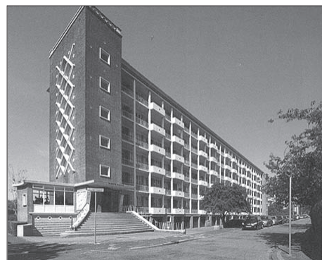
Flatgebouw Wapendal, Ridderspoorweg 2-172 uit 1951-1953
