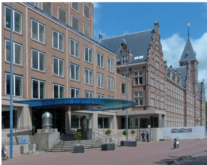
Shell Kantoor aan de Carel van Bylandtlaan
